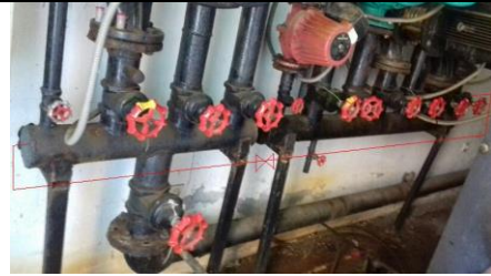
Διάταξη συλλεκτών Με κόκκινη γραμμή το by pass
